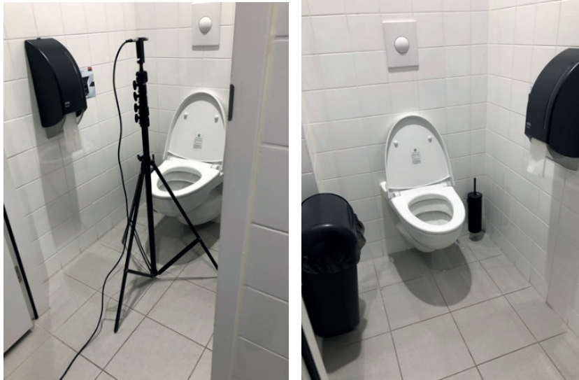
FIGUUR 7.2 LINKS: VACUÛMTOILET 1, TYPE OPTIMA 5 (NIEUW); RECHTS: VACUÛMTOILET 2, TYPE VT910 (HUIDIG)
