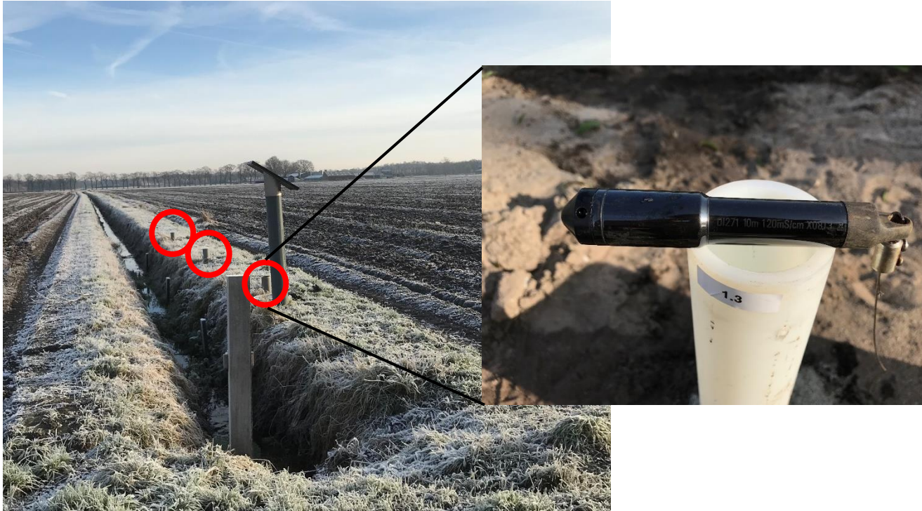
Figuur B9.2 Inspectieputten (rood omcirkelt) van drie drainagebuizen (links). In elke inspectieput is een CTD-diver geïnstalleerd (rechts).
