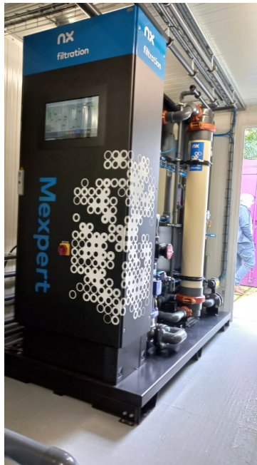
A. OPSTELLING MET 1 MEMBRAANMODULE
