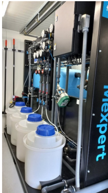
B. OPSTELLING VOOR DOSERING VAN REINIGINGSCHEMICALIËN VOOR DE NF
